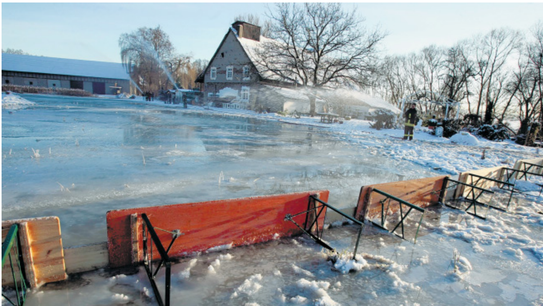
Bierzeltgarnitur auf Eis: Die Tische stützen eine Begrenzung aus Holz. Diese umfasst die fußballfeldgroße Eiswiese und soll verhindern, dass das versprühte Wasser abfließt.
